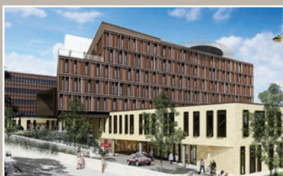
Regionshospitalet Viborg Sjukhus, fallschakt Viborg, Danmark
