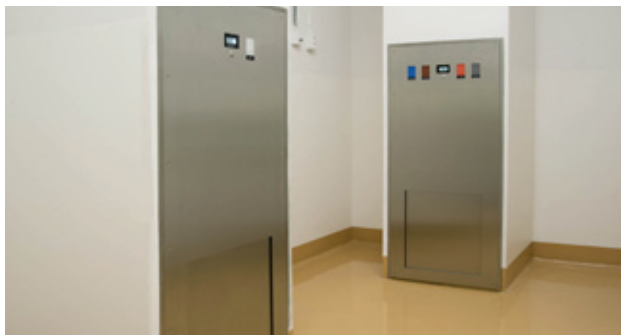
Helautomatiska, beröringsfria inkast gör det enkelt, hygieniskt och bekvämt för personalen att slänga avfallssäckar och tvättsäckar.
